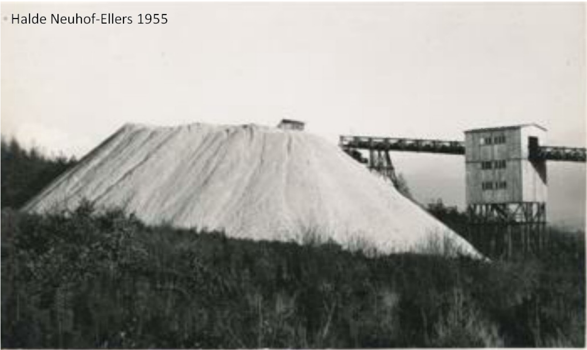
Abbildung 2 – Kalihalde Neuhof-Ellers im Jahr 1955. Die Rückstände wurden ohne Vorbereitung der Aufstandsfläche ins Gelände geschüttet. (Quelle: K+S, 2024)
